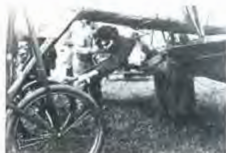
En jupe-culotte de l'époque, Mme Cayat de Castilla s'apprête au décollage. Elle est retenue sous l'avion. Son parachute de 95 m 2 est fixé sous l'aile de l'appareil. Elle y est reliée par un harnais hybride. Nous étions en 1914.
